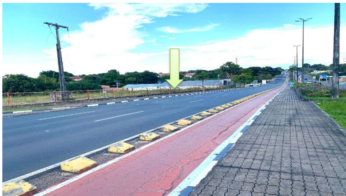
Imagem : Av. Glaycon de Paiva principal via de acesso ao empreendimento, com indicação do lote
