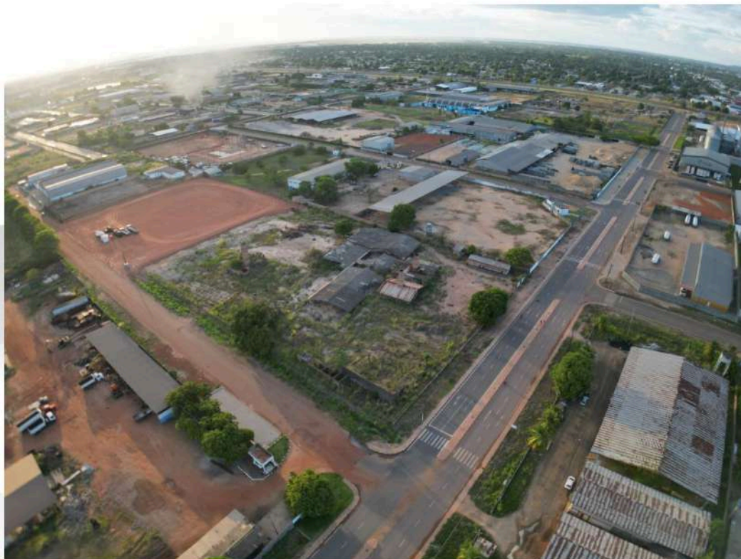
Foto 01 – Vista da Esquina
