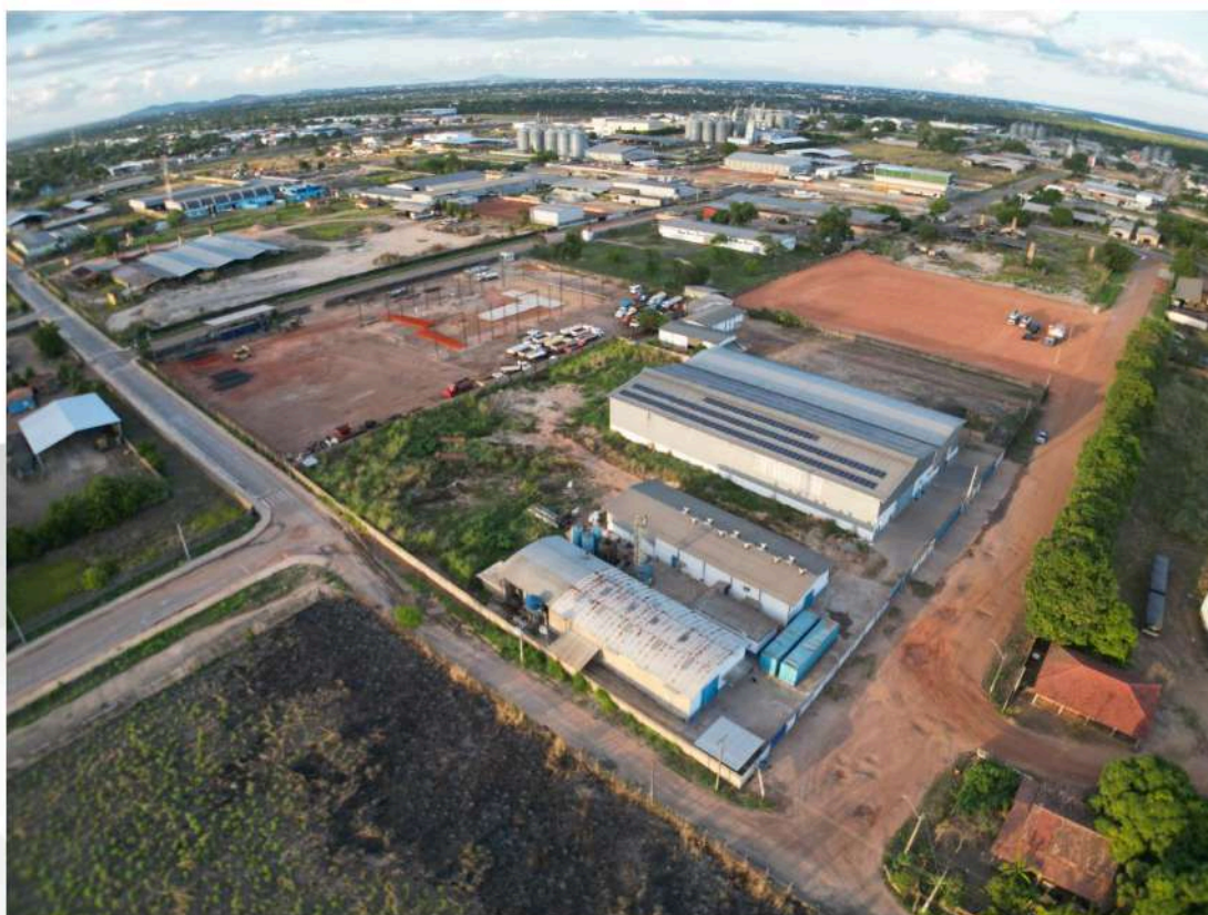
Foto 03 – Vista Aérea do Lote e da Via de Acesso
