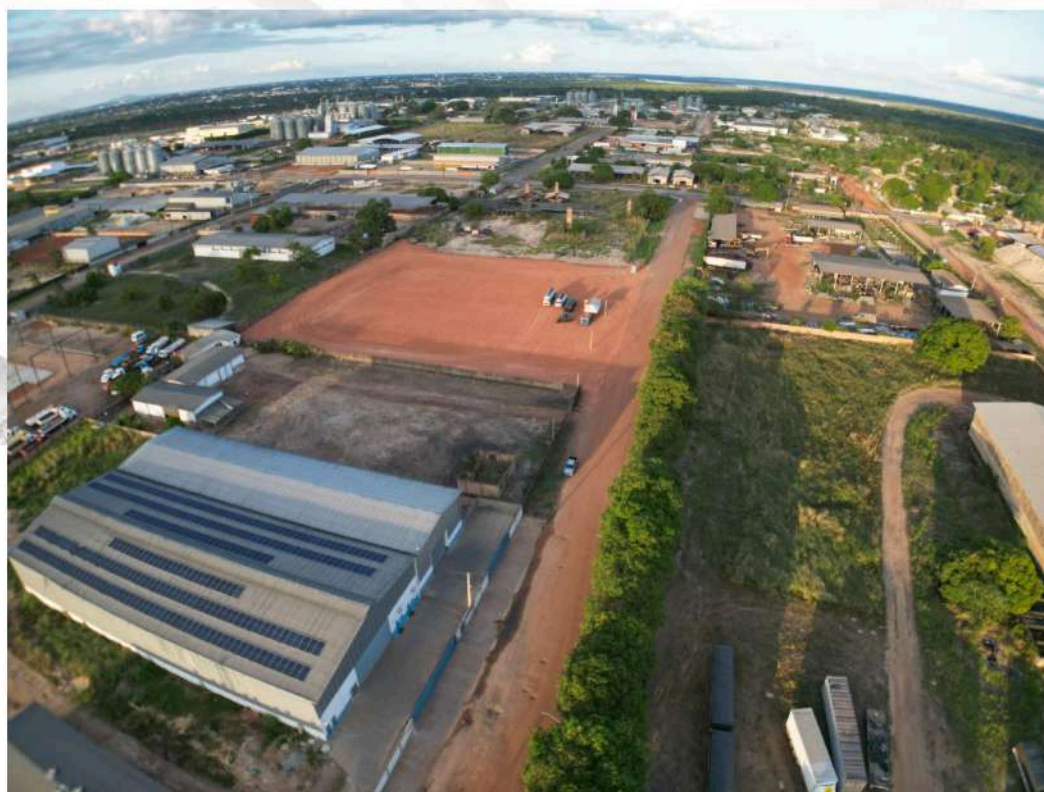
Foto 02 – Vista Aérea do Lote e da Via de Acesso
