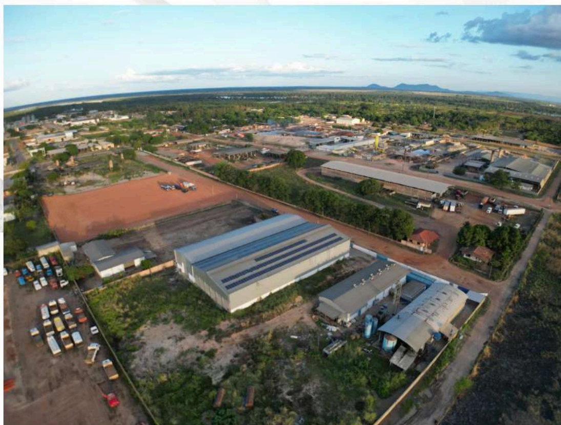
Foto 04 – Vista Aérea Lateral direita
