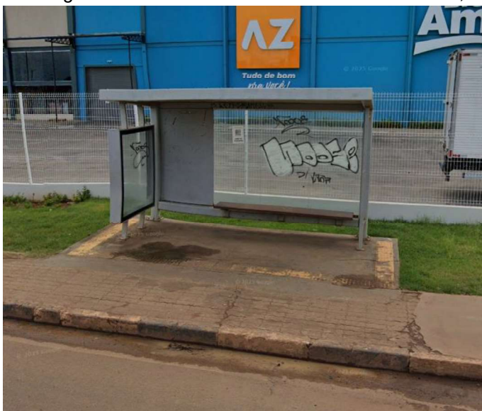
6. Abrigo de ônibus à Avenida João Alencar, distante 630,00 m do acesso ao empreendimento.
