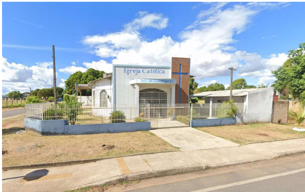
Igreja Nossa Senhora do Livramento, à Rua Sizeano do Carmo Cavalcante, esquina com a Rua Antônio da Costa Uchôa.
